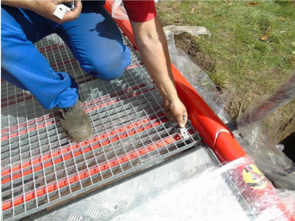
Anschrauben der Halterungen mit Schrauben von der Unterseite des Gitters mit Unterlegscheiben und Muttern.
