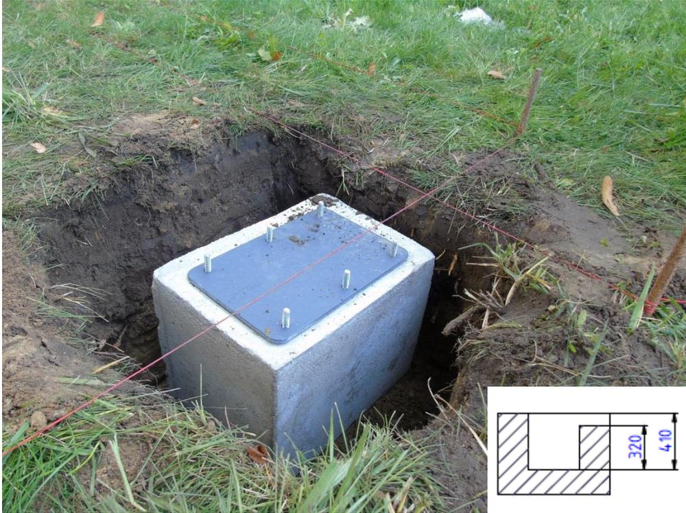
Die Einbettungstiefe des Steins muss der Zeichnung „Querschnitt“. Maße der Steine: Höhe 320 mm x Breite 270 mm x Länge 410 mm.
