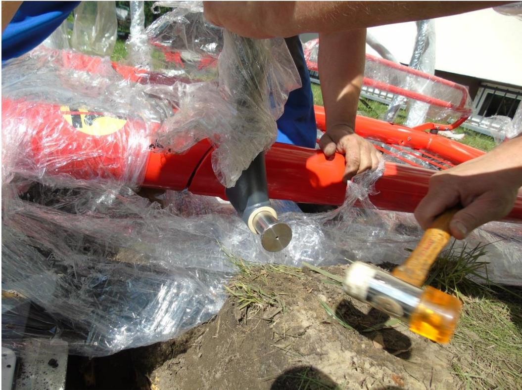
Nach Montage der Auffahrt die Bolzen des Distanzrahmens in das Podest hineinschlagen.
