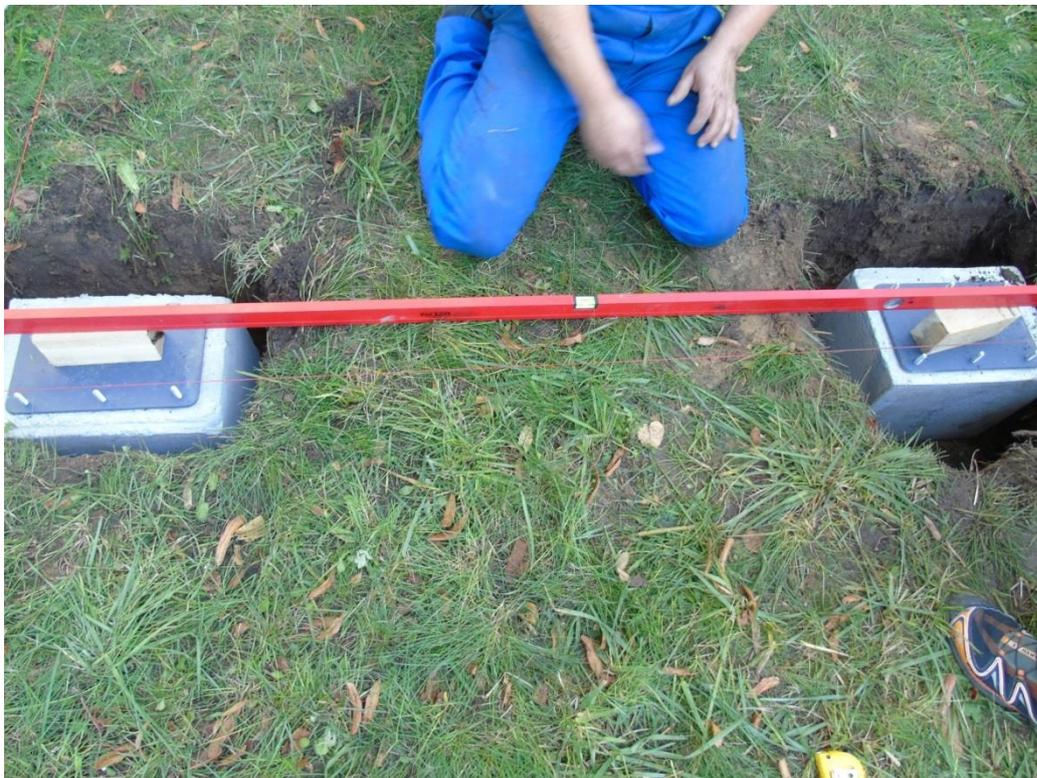
Überprüfung der horizontalen Ausrichtung der Steine mit der Vorder- und Rückseite der Schaukel.
