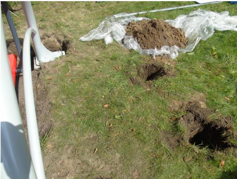
Um die Tafel besser im Boden zu verankern, wird empfohlen die Löcher mit fertigem Zementmörtel oder schnellabbindendem Beton zu füllen und die Füße des Plattenrahmens in dieses Material einzusetzen. Um den Mörtel nicht sichtbar zu machen, sollte man ihn mit einer Erdschicht von mind. 5 cm bedecken, auf der der zuvor entfernte Rasen verlegt werden kann.
