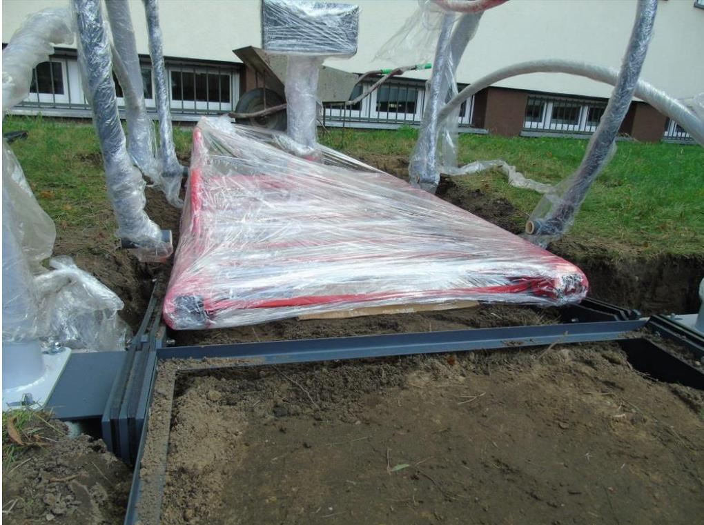
Verbinden der Arme mit der Plattform, **Bolzen bis zur Hälfte hineinschieben. ACHTUNG! Nach Montage der Auffahrt zur Schaukel die Bolzen vollständig hineindrücken.**
