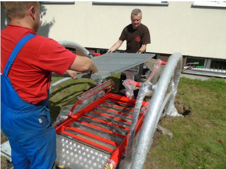
Auflegen der Halterung zur Befestigung des Gitterbodens an der Konstruktion der Plattform.
